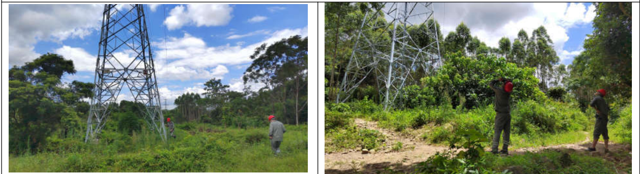
项目建设区植被恢复情况图
