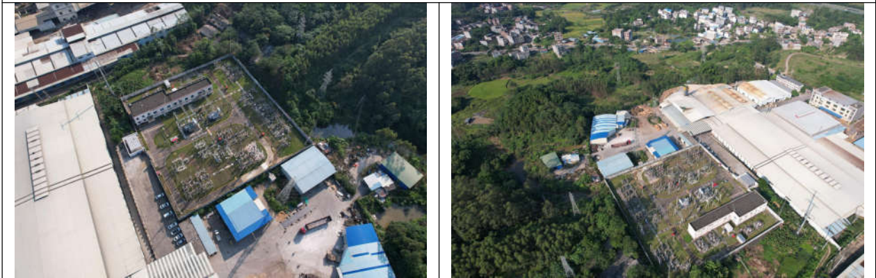
间隔扩建区绿化植被恢复情况
